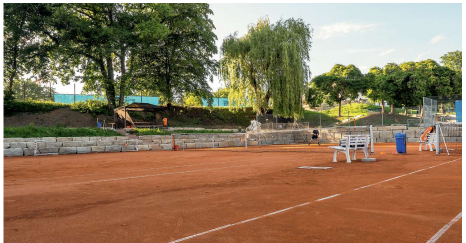
Insgesamt vier Plätze wurden komplett saniert und der alte Baumbestand dabei integriert.
